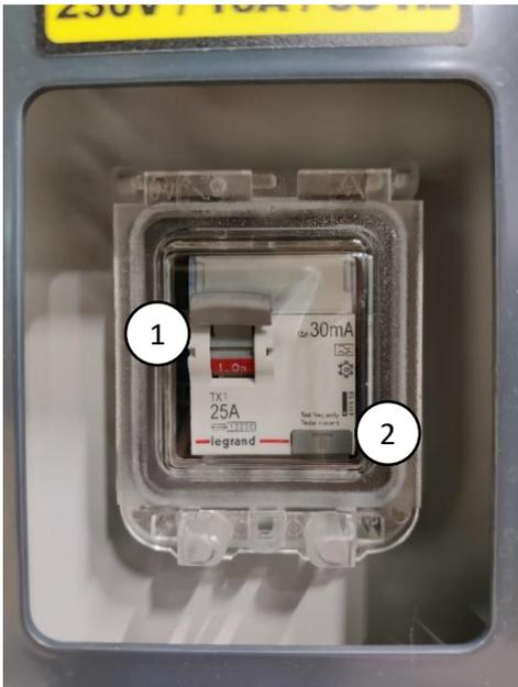
Le dispositif à courant résiduel ou interrupteur d'unité RCD (1) doit être relevé pour qu'un dispositif de 230 V puisse fonctionner, y compris les prises de 230 V de la plateforme. L'unité RCD peut être testée en appuyant sur le bouton TEST (2) situé sur l'unité. Si l'interrupteur ne descend pas, il y a peut-être une défaillance au niveau de l'unité ou le câble de connexion n'est pas branché sur le secteur.
