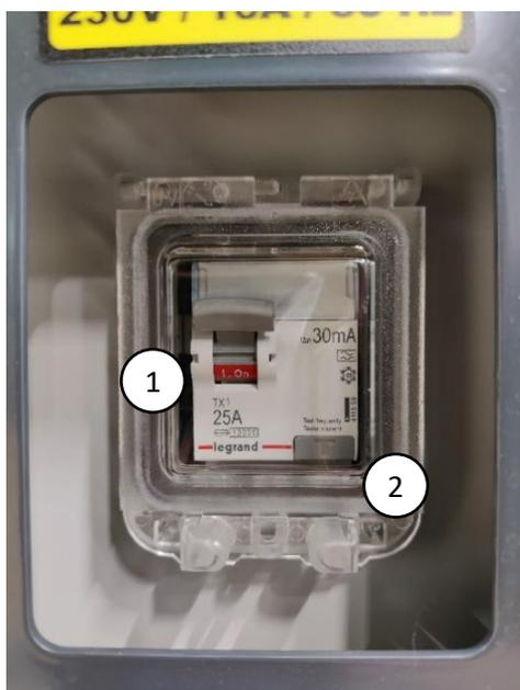
L'interruttore del dispositivo di corrente residua o unità RCD (1) deve essere in posizione sollevata affinché qualsiasi dispositivo a 230 V sia funzionante, comprese le uscite a 230 V sulla piattaforma. L'unità RCD può essere verificata premendo il pulsante di TEST (2) sull'unità. Se l'interruttore sull'unità non si abbassa, l'unità è difettosa o il cavo di collegamento non è collegato alla rete elettrica.
