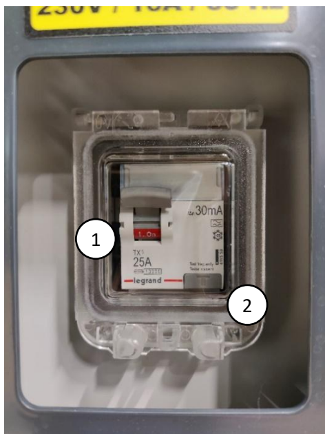
Figur 8. Reststrøm-enhet
