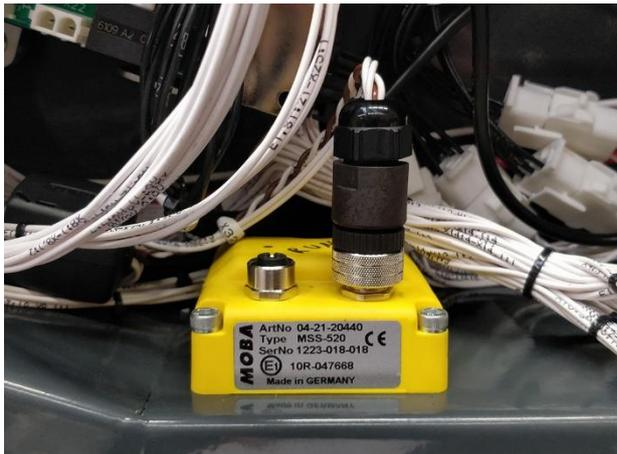
Figure 29 capteur d'inclinaison (châssis)
