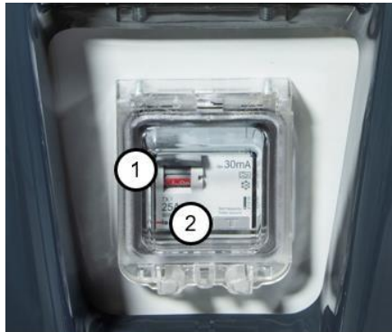
Zdjęcie 10. Włącznik różnicowo-prądowy.
